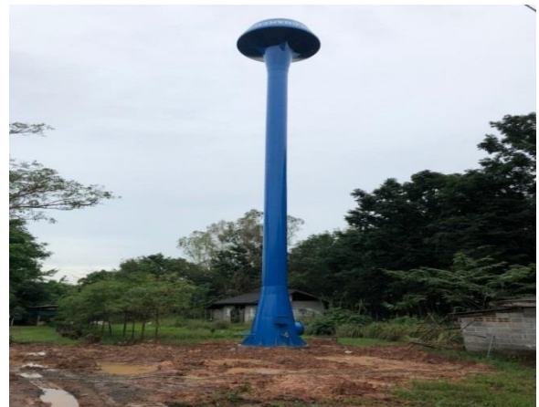
ก่อสร้างหอถังน้ำรูปแชมเปญ ความจุ ๒๐ ลูกบาศก์เมตร
